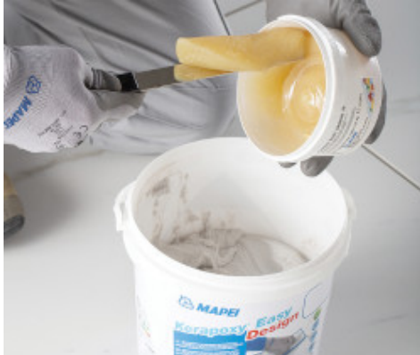
Kaada kovete (komponentti B) komponentin A astiaan
