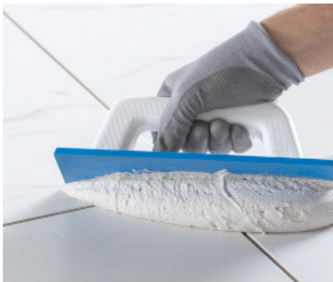
Levitä Kerapoxy Easy Design Mapei-lastalla
