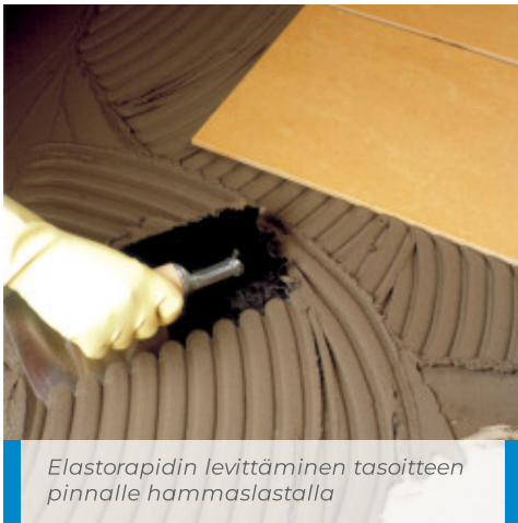
Posliinilaattojen asentaminen Mapelasticilla vedeneristetyn tasoitteen päälle
