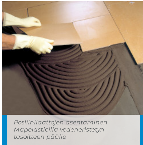
Posliinilaattojen asettaminen vesivaneri alustalle Elastorapidin avulla
