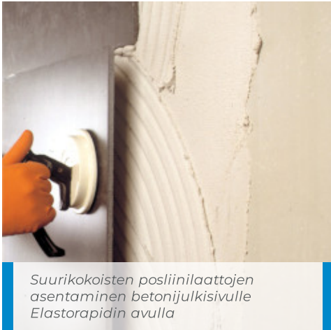
Elastorapidin levittäminen tasoitteen pinnalle hammaslastalla
