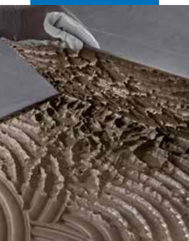
Ohuen porcellanato-laatan kiinnityslaastikerroksen tarkastus
