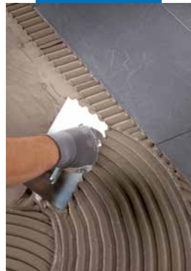
Laastikampa puolipyöreällä (9 mm) hammastuksella
