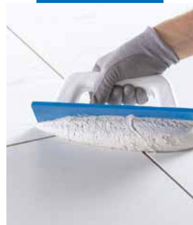
Levitä Kerapoxy Easy Design Mapei-lastalla
