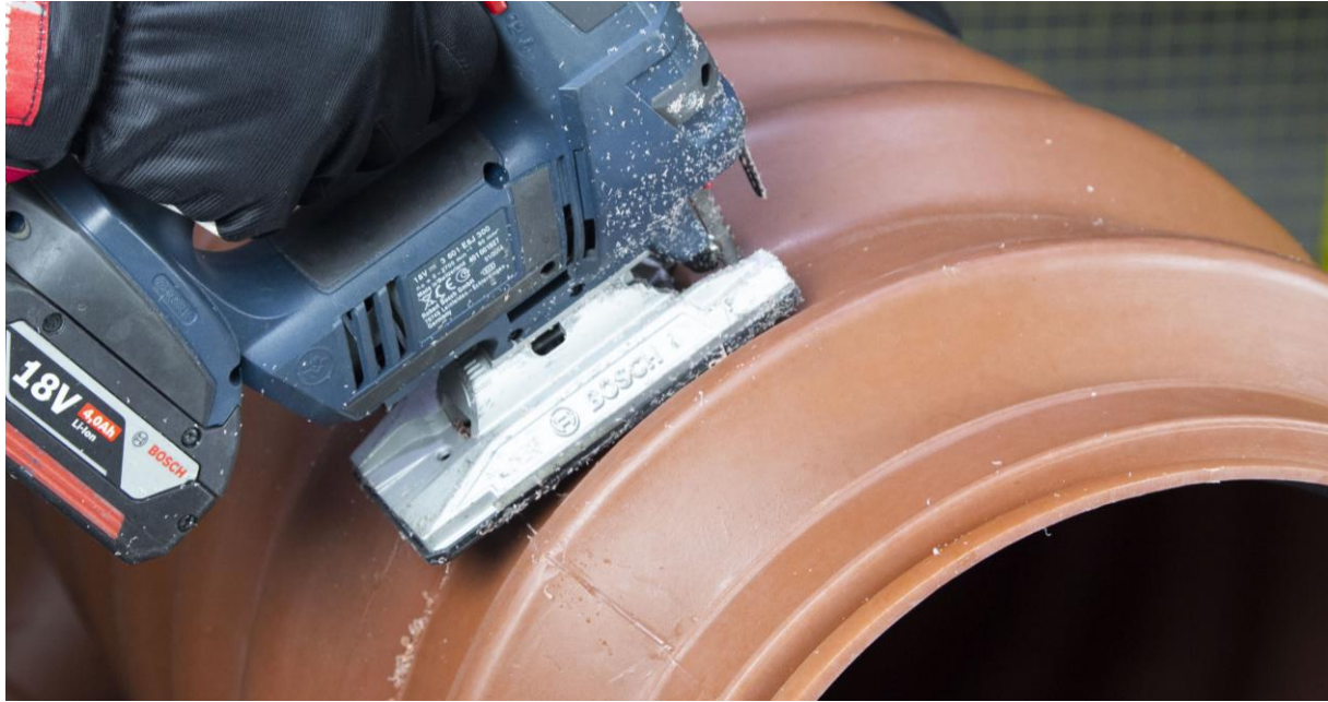
Sahaa teleskooppi rengasosa irti kaivon rungosta
