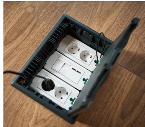
Lattiarasia L 6 moduulin asennuksessa.
