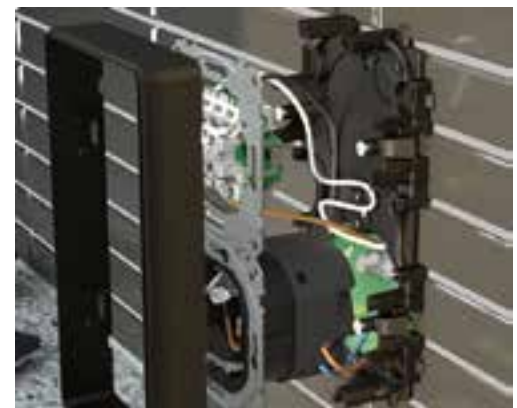
Käytä vanhaa upporasiaa ajastinpistorasiaa varten.
