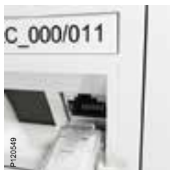
P120549 Liittimet käännetty johtojen irrottamisen helpottamiseksi.
