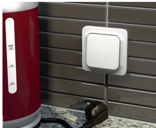
Vanha asennus, jonka paikalle tarvitaan uusi pistorasia.
