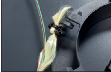
2. Poista kuitukaapelista veto kiinnittämällä kevlar-osa kuidunpitimeen.
