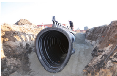
Muna-profiilin ansiosta Qdrainilla on loistavat virtausominaisuudet.
