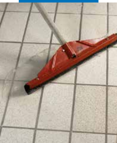
Pesuvesijäämien poistaminen lattialastalla
