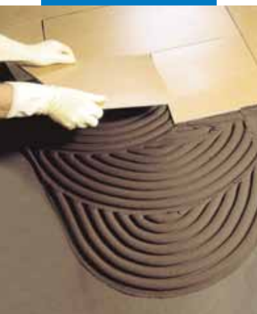
Elastorapid-laatoitus Mapelastic-alustalle
