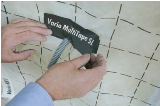
Kaapelien läpivienneistä tehdään ilmatiiviit VARIO MultiTape SL -teipillä. VARIO Läpivientitiiviste on niin ikään ihanteellinen useiden muiden asennusten tiivistämiseen.
