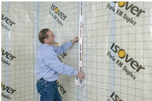
VARIO KM Duplex UV limitetään vähintään 10-15 cm, ja ilmatiivis liitos vahvistetaan joko VARIO KB3- tai VARIO MultiTape SL -teipillä. Seinän ja lattian liitoskohdat tiivistetään joko VARIO DS- tiivistemassalla, jolloin rakenteesta tulee ilmatiivis.
