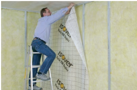
Sen jälkeen, kun metallista/puusta tehty runko on kiinnitetty lattiaan, seinään ja kattoon, metallista/puusta tehty runkoon asennetaan VARIO KM Duplex UV-höyrynsulku.
