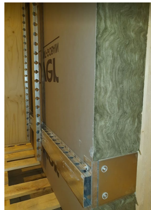
Kuva 10. SerpoVent U-Seinäkannakeosat A-B, sekä SerpoVent Hattuprofiilit OL-33 eristeeseen ja CLT-levyyn asennettuna
