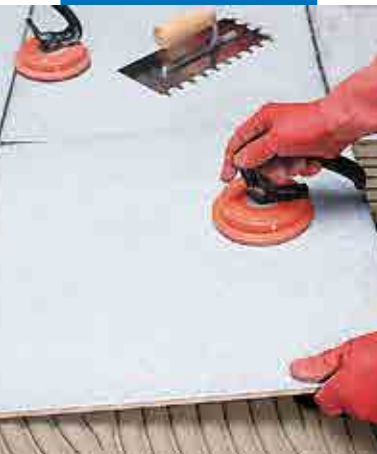
Isokokoisten laattojen asennus
