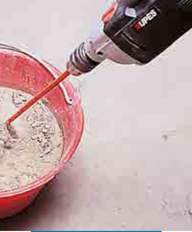
Adesilex P4-laastin sekoittaminen
